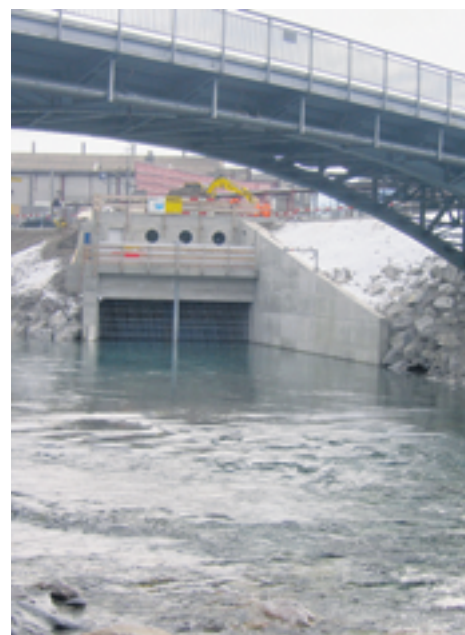
Auslaufbauwerk (Bild: J. Ludwig)
