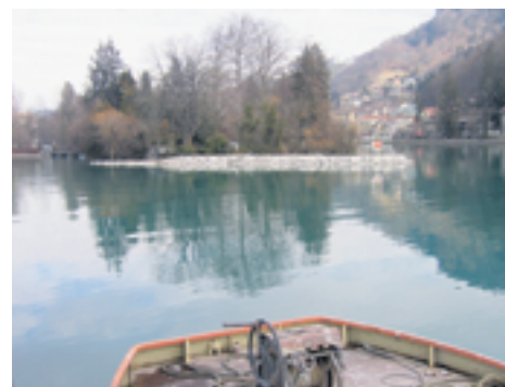
Trichter Eingang Schifffahrtskanal mit Aufschüttung (Bild: J. Ludwig)
